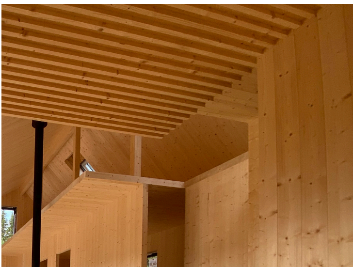
Dekkeelement med ribber i gran.
