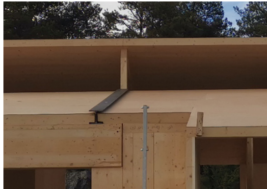
Eksempelet viser forsterkning ved HEB-bjelke
