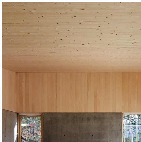
Tak i gran og veggelementer i osp.
