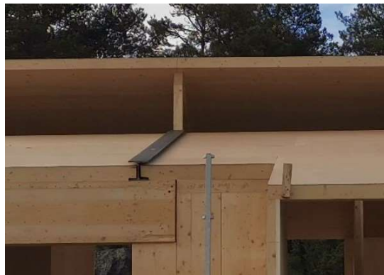
Eksempelet viser forsterkning ved HEB-bjelke
