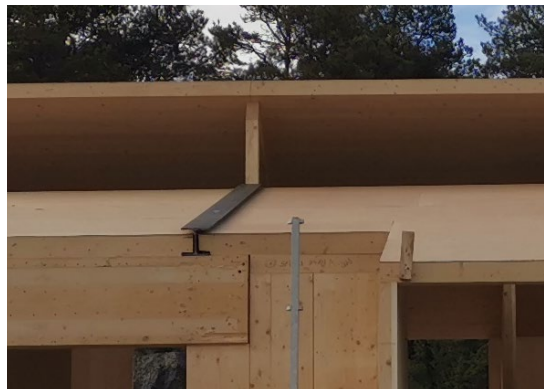
Eksempelet viser forsterkning ved HEB-bjelke
